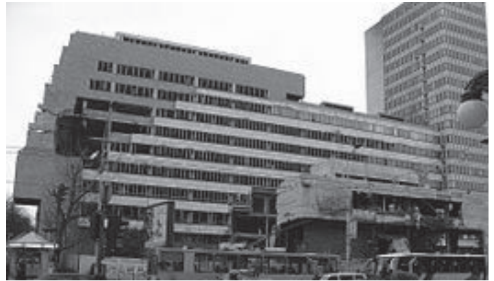
Le bâtiment de l'Etat Major Serbe après les bombardements de l'OTAN en 1999.
